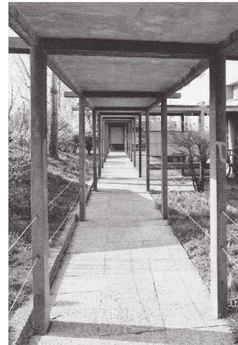
Henri-Dunant 1-9 (bloc H) la galerie couverte, démolie
