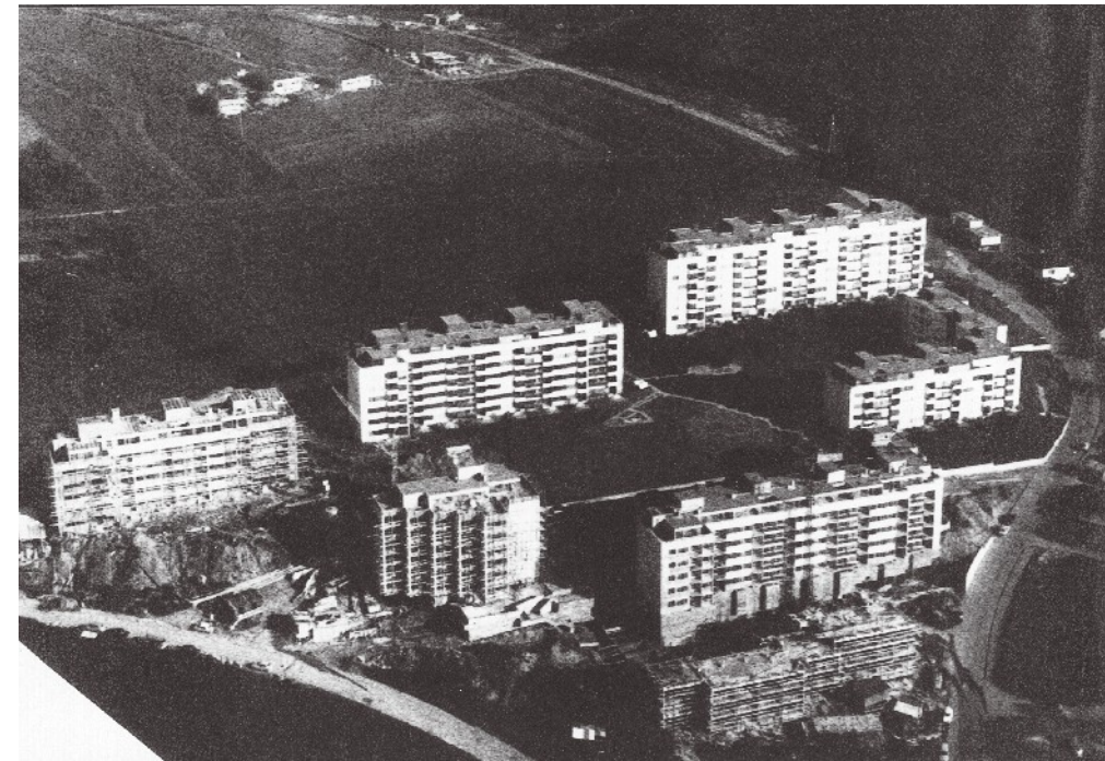
Vue aérienne du chantier, vers 1964
