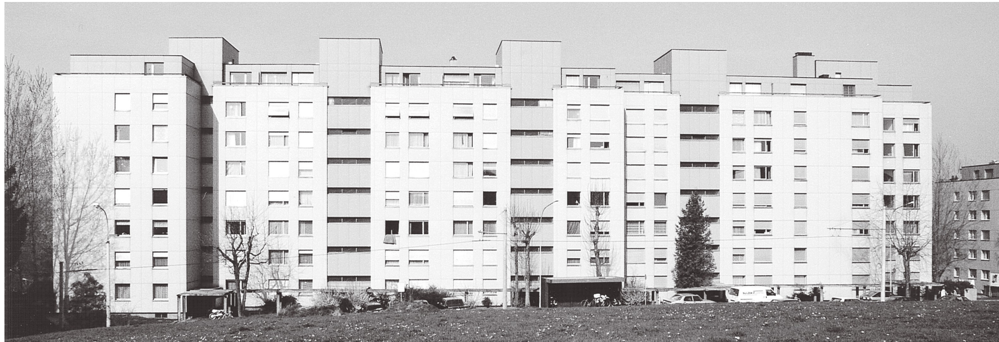
Route Henri-Dunant 1-9 (bloc H), élévation est
